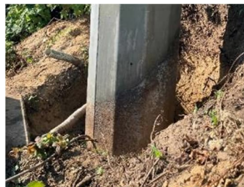
Abbildung 9: Korrosion im erdüberschütteten Bereich
